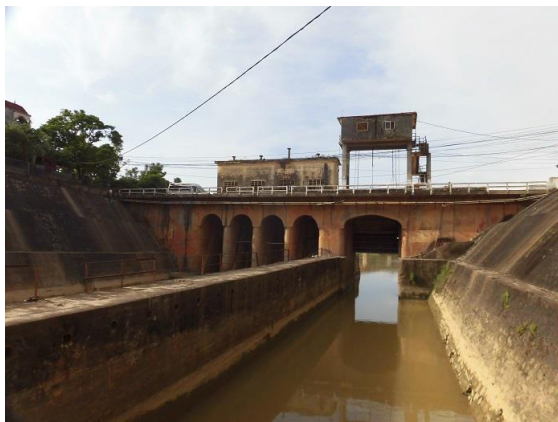
写真-3 築100年以上経過した頭首工
