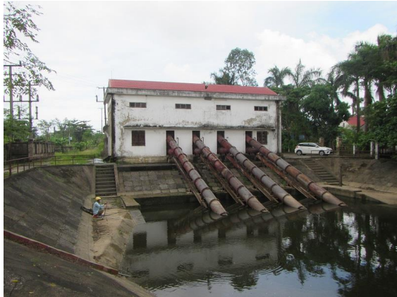
写真-1 ポンプ場
