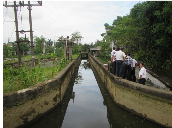
写真-2 RC造の開水路
