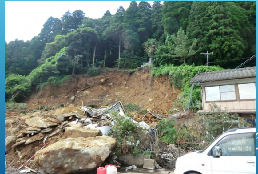
がけ崩れ (2012, 熊本県阿蘇市)
