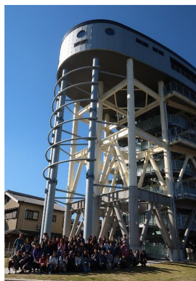
<黒潮町佐賀地区津波避難タワー見学>
