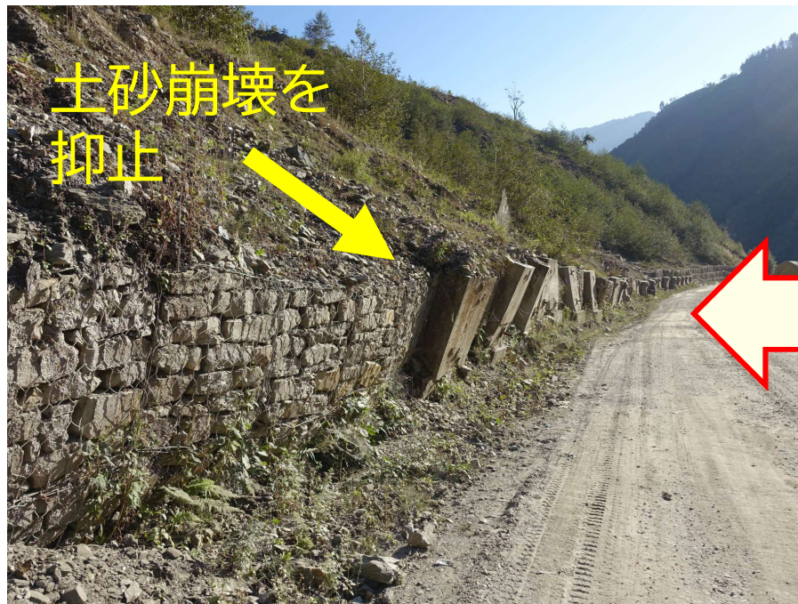
道路閉塞を防いだ蛇籠擁壁 (ネパール国 アラニコ・ハイウェイ)
