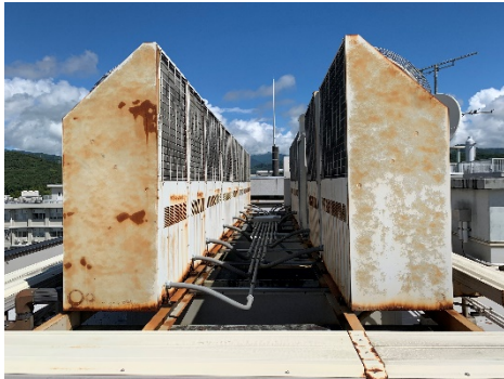
改修前：老朽化した空調室外機
