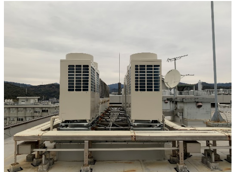
改修後：高効率型空調設備に更新
