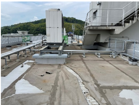
改修前：老朽化により破れた防水シート （令和4年度（朝倉）教育学部3号館屋上防水改修）
