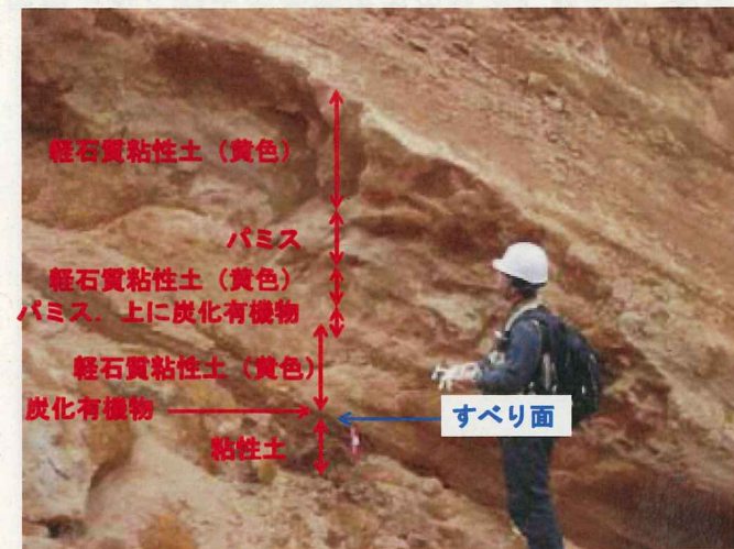
今回の調査では最下層の凝灰岩質粘性土と軽石質粘性土の間をすべり面と見た(すべり面勾配27°)。
