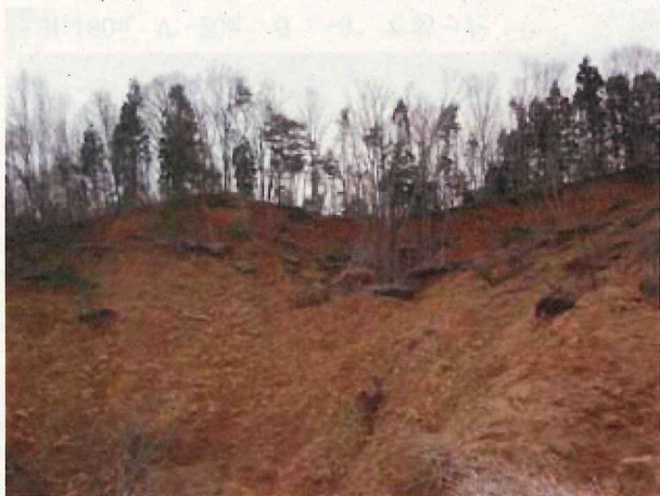
火砕流堆積物，降下軽石層の層状構造があり，オレンジ色の降下軽石層の下部にすべり面があるように見える。
