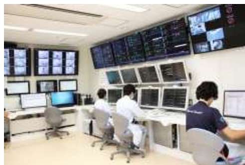
本館4階A棟 スーパーICU モニター
